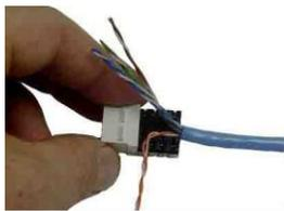
1、把橙色线对在相应的插槽，让护套背对插座。DO NOT UNTWIST WIRES!
