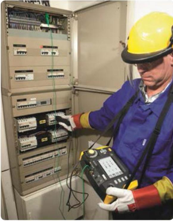
在民用、第三产业和工业环境领域，这些新型多功能安装测试仪可用于检测电气设备是否符合适用标准的规定。无论待测建筑属于什么类型（民用、公共建筑、工业用等），该项检验都具有强制性，从而确保设备是安全的。
